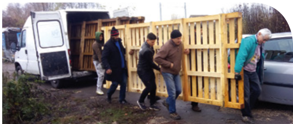
Novembre 2018, reconstruction du squat du canal
